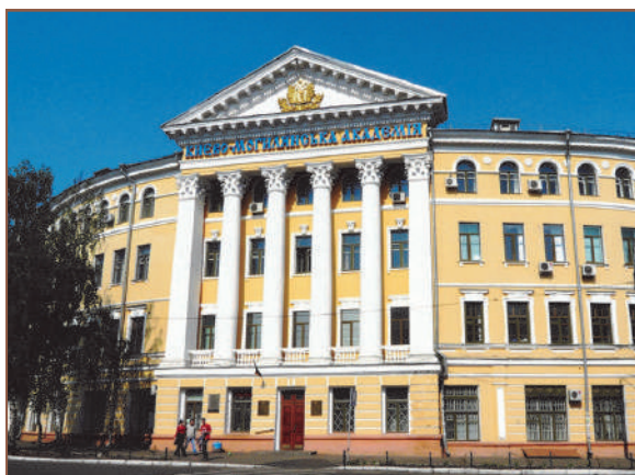
Головний корпус будівлі Києво-Могилянської академії, розташований на Контрактовій площі, м. Київ
