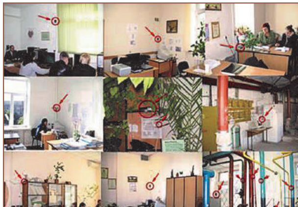
Розміщення температурних датчиків системи енергоменеджменту університету
