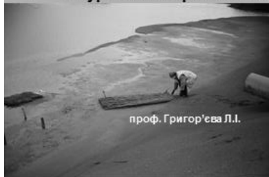
Вигляд ділянки схилу шламосховища, вкритої очеретяними матами
