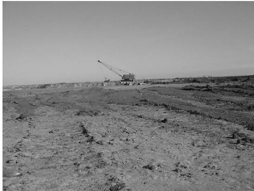
Рис. 4.2.2. Нанесення шарів мулу (грунту) на поверхню хвостосховища червоних шламів на МГЗ
