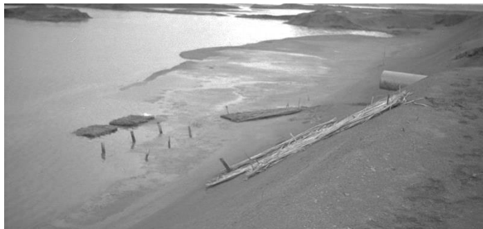
Рис. 3.5.2.1. Дернина та очеретяні мати вкриті водою
