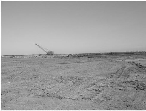
Рис. 4.2.1. Нанесення шару глини на поверхню хвостосховища червоних шламів на МГЗ
