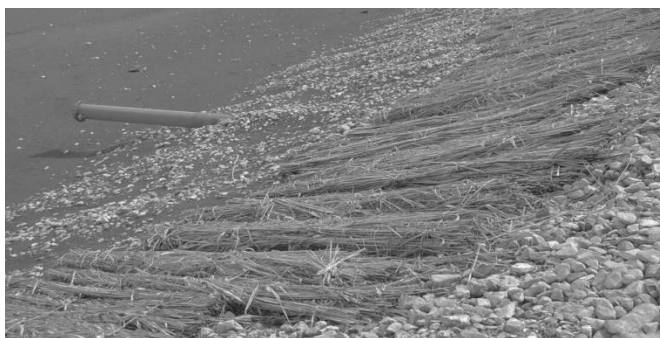
Рис. 3.4.2.3. Розміщення очеретяних матів на відкосі дамби
