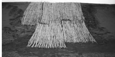
Вигляд ділянки схилу шламосховища, вкритої очеретяними матами
