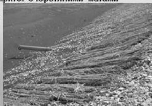
Вигляд ділянки схилу шламосховища, вкритої очеретяними матами
