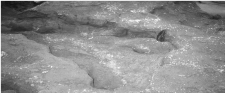
Рис. 3.2.2. Покриття поверхні шламосховища водополімерною плівкою
