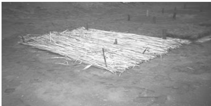
Рис. 3.4.2.4. Розташування очеретяних матів на гладкій ділянці шламосховища
