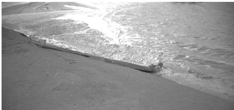
Рис. 3.5.1.3. Хвильові вимивини на схилі насипної дамби
