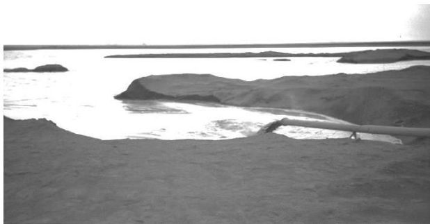
Рис. 3.5.1.4. Скидання шламової пульпи поблизу дослідної ділянки
