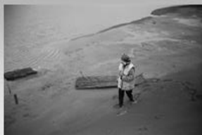
Вигляд ділянки схилу шламосховища, вкритої очеретяними матами
