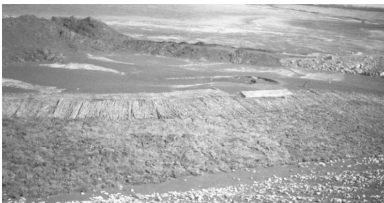
Рис. 3. Біопокриття агресивної поверхні шламосховища № 1 МГЗ
