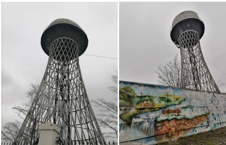
Рис. 1.11. Водонапірна вежа та її міцний каркас (фото автора).
