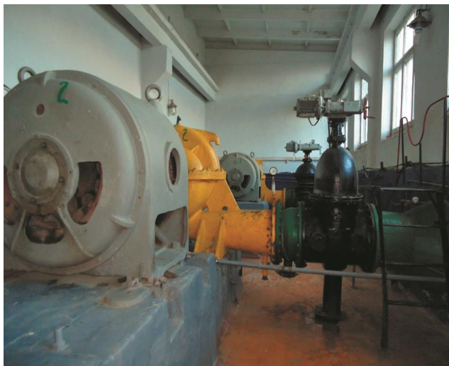
Рис. 1.18. Технічне обладнання для додавання коагулянтів (фото Марини Ілясової).
