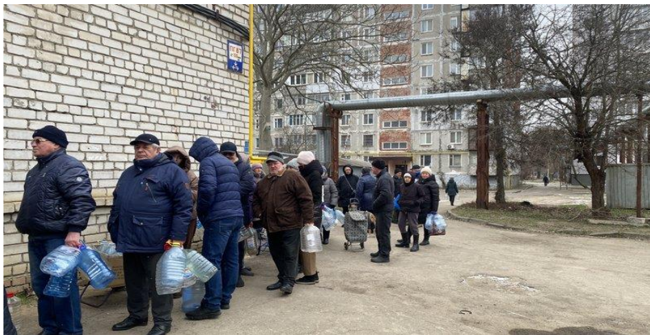
Рис. 1.35. Поки проводяться ремонтні роботи на дюкері люди стоять у чергах за водою (фото з відкритих джерел).
