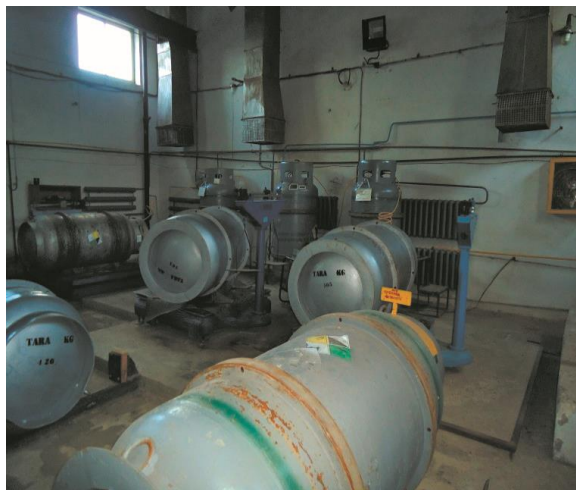
Рис. 1.17. Ежекторна, де відбувається процес хлорування води (фото Марини Ілясові).
