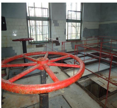
Рис. 1.16. Камери сіток, де відбувається фільтрація – перший етап водопідготовки води (фото Марини Ілясової).
