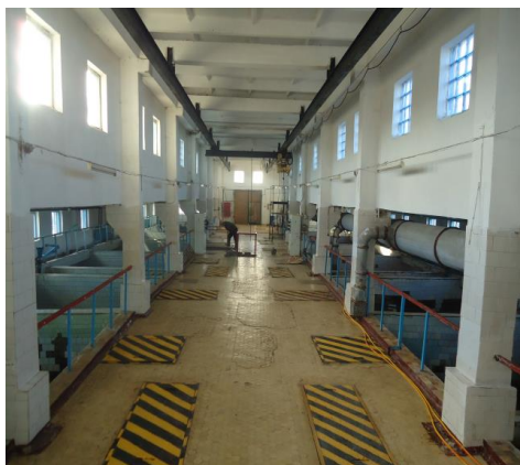
Рис. 1.16. Камери сіток, де відбувається фільтрація – перший етап водопідготовки води (фото Марини Ілясової).
