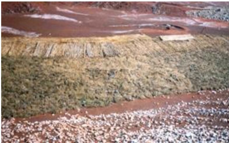
Рис. 9. Закріплення ділянки поверхні шламосховища №1 червоних шламів МГЗ засобами з рослинної сировини.
