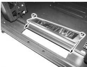
Рисунок 6.45 – Установка щіткового кабельного вводу в основі шафи
