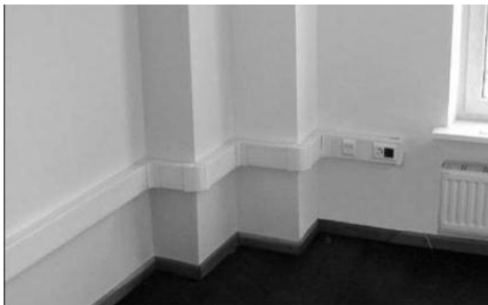
Рисунок 6.27 – Периметральний монтаж кабельної траси
