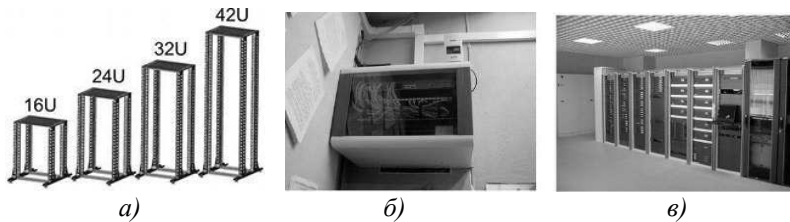
Рисунок 6.41 – Телекомунікаційні стійки (а) та шафи: б – настінна; в – підлогова
