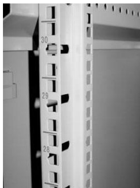
Рисунок 6.42 – Маркування висоти шафи фірми TWT (номери юнітів)
