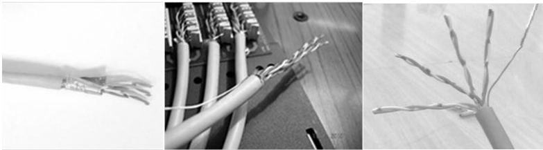
Рисунок 6.22 – Підготовка витої пари для монтажу в патч-панель
