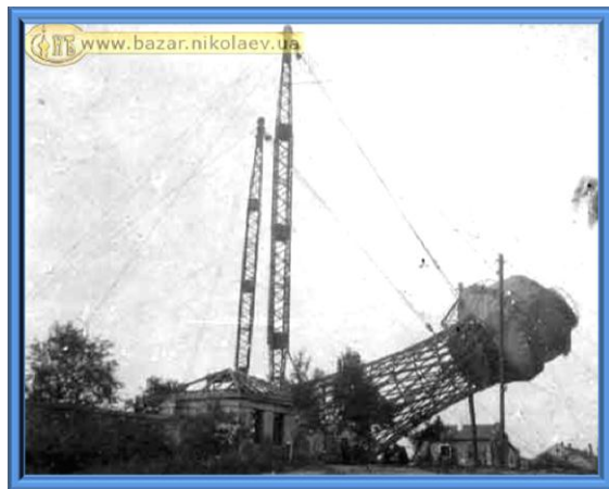
Рис. 58. Разрушенная Шуховская водонапорная башня
