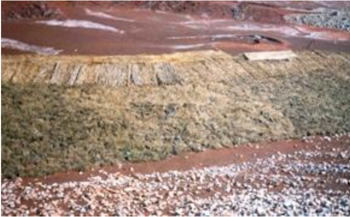
Рис. 21. Закріплення ділянки поверхні шламосховища № 1 червоних шламів МГЗ засобами з рослинної сировини
